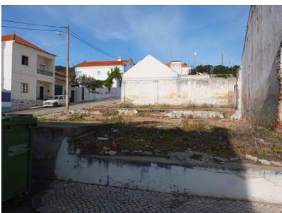
Figura 1 – espaço demolido actualmente sem função
