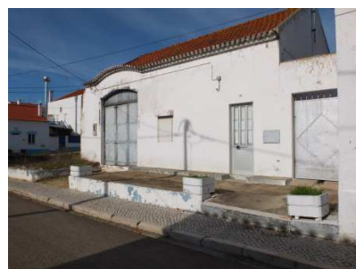
Figura 3 - Edifício do Bairro Novo degradado
